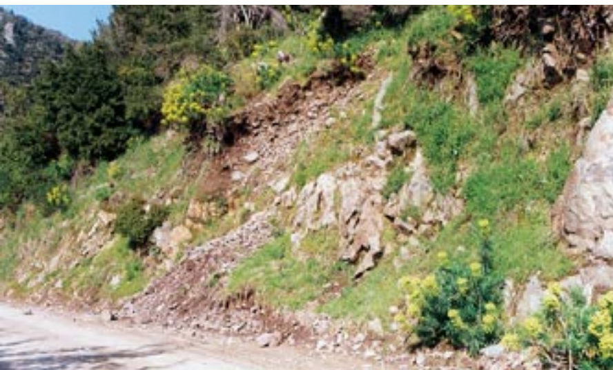
Έναρξη φυσικής αποκατάστασης πρανούς, Φωτ. Αρχείο ΕΚΒΥ / Γ. Γουδέλης
