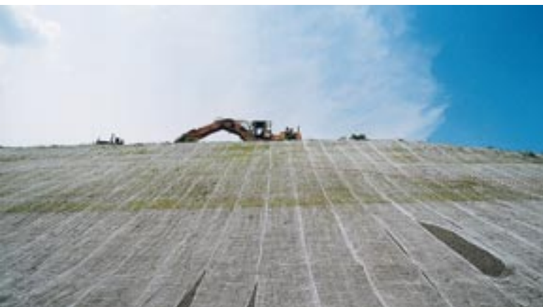
Εργασίες αποκατάστασης πρηνών στην Εγνατία Οδό. Φωτ. Αρχείο ΕΚΒΥ / Μ. Κατσακιώρη
